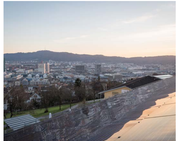
Die Photovoltaik-Anlage auf dem Dach des Stadtspitals Waid produziert bis zu 40 Prozent des Strombedarfs.
