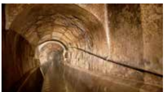
Sammelkanal unter der Bahnhofstrasse. Foto: Markus Kriesi.
