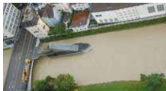
SZU-Station Selnau beim Hochwasser 2005. Foto: AWEL, Kanton Zürich.
