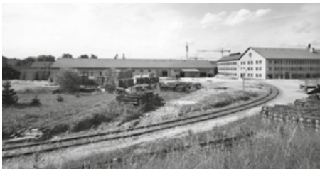
Ziegelei Tiergarten. Heute steht an Stelle der Fabrik das Quartier «Im Tiergarten». Foto: Baugeschichtliches Archiv der Stadt Zürich.
