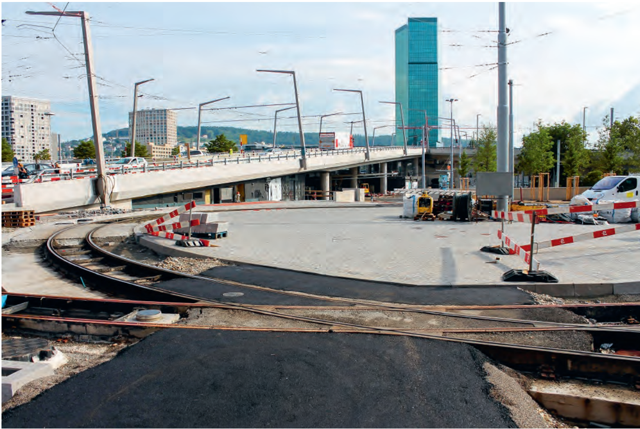
Hardplatz: Baustelle Tramverbindung Hardbrücke, Foto: Stadt Zürich, Tiefbauamt
