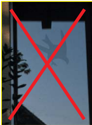
Ungeeignet: Schwarze Silhouetten sind oft kaum zu erkennen und haben einen schlechten Wirkungsgrad.
