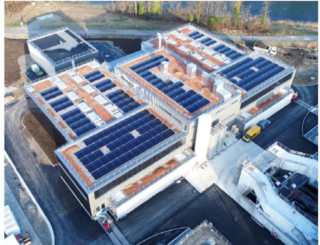
**Zwecks Energiegewinnung sind das Dach und die Südfassade der Ozonungsanlage mit Solarpanels ausgerüstet.**
