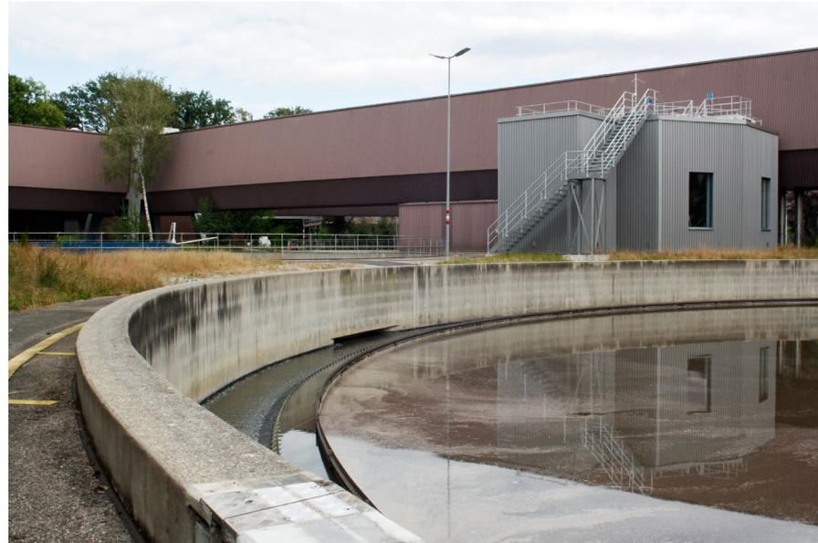
Die neue Dosierstelle im grauen Gebäude setzt dem Überschussschlamm Flockungsmittel zu, wodurch sich dieser in den Vorklärbecken besser absetzt.
