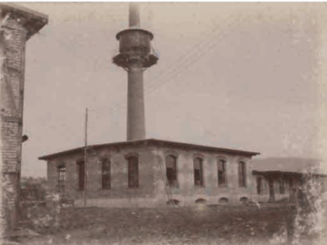
Südlich von dieser Halle kamen **das Kesselhaus und das 40 Meter hohe Sichtbacksteinkamin** zu stehen. Letzteres steht seit 1997 unter Denkmalschutz. Es ist ein aussergewöhnlicher Bau wegen seines blechverkleideten Wasserreservoirs mit 50 Kubikmetern Inhalt, das in 25 Meter Höhe angebracht ist. (Abb. 18)
