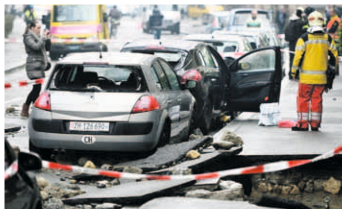
Asphalttrümmer richten einen grossen Sachschaden an
