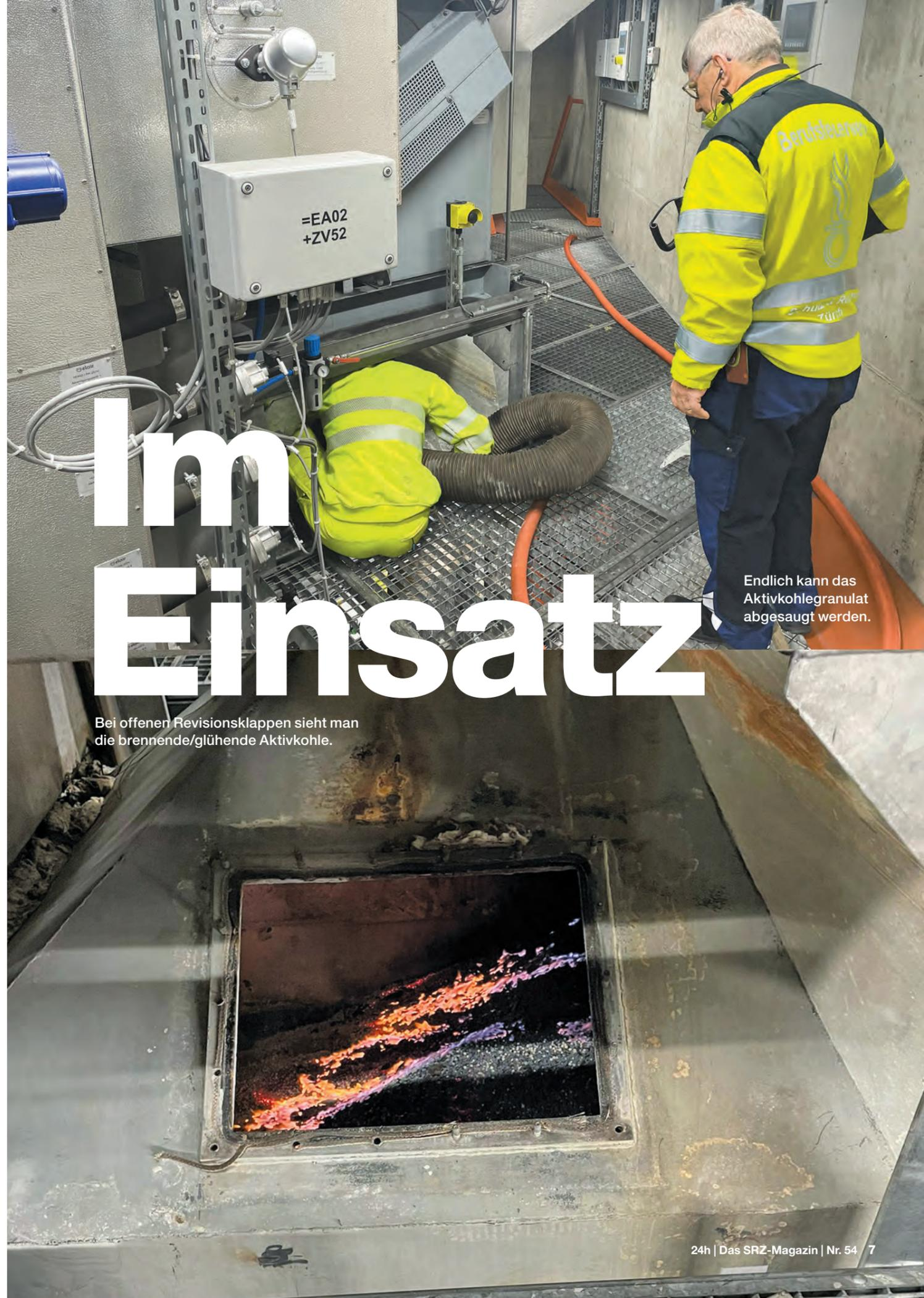
Endlich kann das Aktivkohlegranulat abgesaugt werden.
