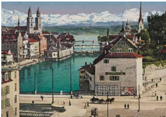
Wo heute das Heimatwerk zu finden ist, entsteht vor 100 Jahren die erste ständige Brandwache.
