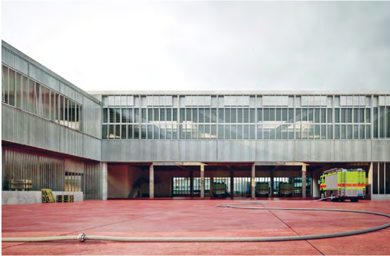
Das L-förmige Arealinnere dient als Zufahrt, Anlieferung und Manövrierfläche und kann auch als Übungsplatz genutzt werden.
