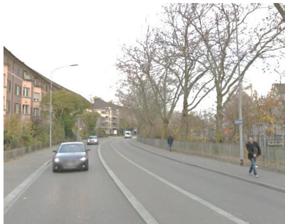
Abbildung 6-7: Beispiel Mehrzweckstreifen (Seebahnstr.)
