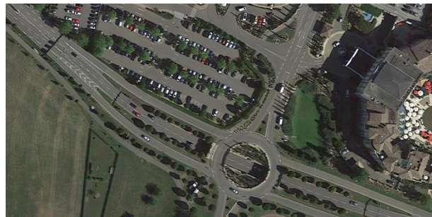
Unterführung Kreisel Ortseingang
