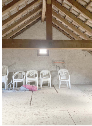
Estrich über Garderoben
